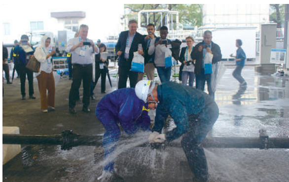
▲研修・開発センターで漏水修理を見学
